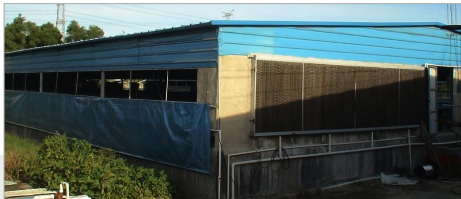
猪舍装配温控卷帘，根据气温变化自动升上降
