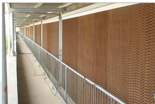
根据猪群在不同生长阶段所需的猪舍面积和空间，每栋配置相应功能的水帘风机和排气变频风扇
