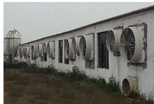
根据猪群在不同生长阶段所需的猪舍面积和空间，每栋配置相应功能的水帘风机和排气变频风扇
